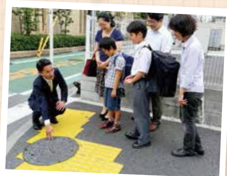
雨で滑りやすいマンホールに滑り止めを加工
