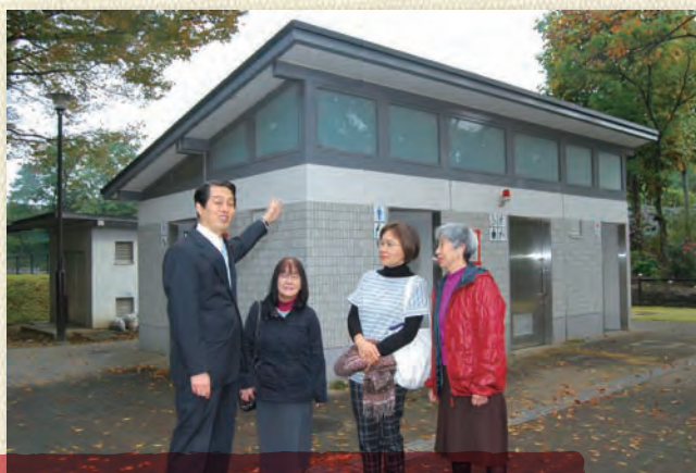
災害時対応型トイレの設置を実現 (戸山公園内)
